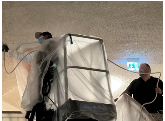
In einer Nachtaktion wird die Decke gespritzt
