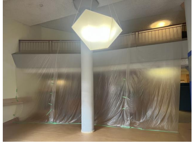
Die Empore wird mit Folie abgehängt
